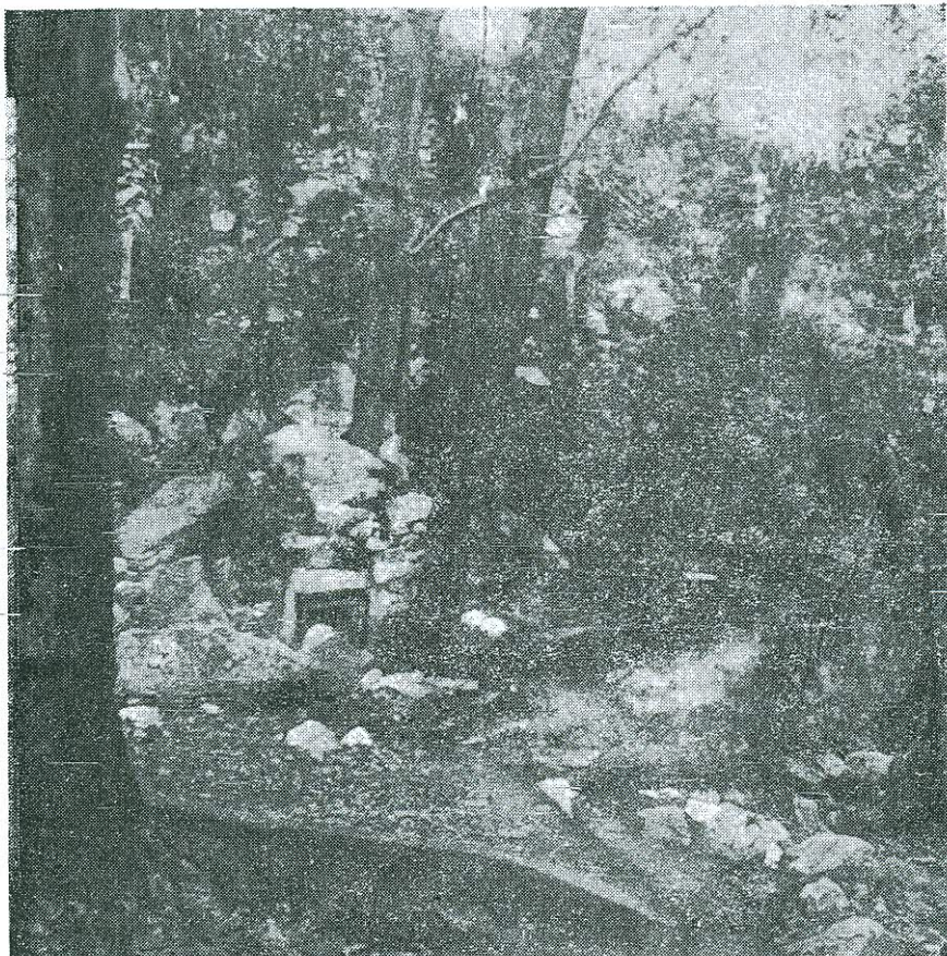
(Είκ. 8). Το στόμιο εξόδου της φυσικής σήραγγας όπως διευθετήθηκε με τεχνικό έργο έξω απ' το Μοναστήρι.
