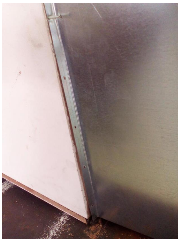
fig. 78 Πρόχειρη τοποθέτηση του υποδοχέα ανεμιστήρα με ξυλόβιδες.
