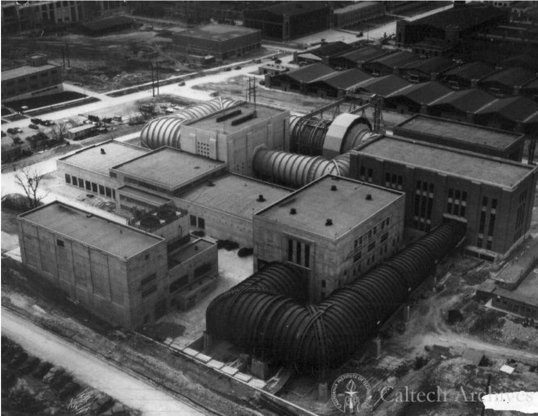
fig. 21 Εγκαταστάσεις Wright Field Dayton, Ohio USA.
