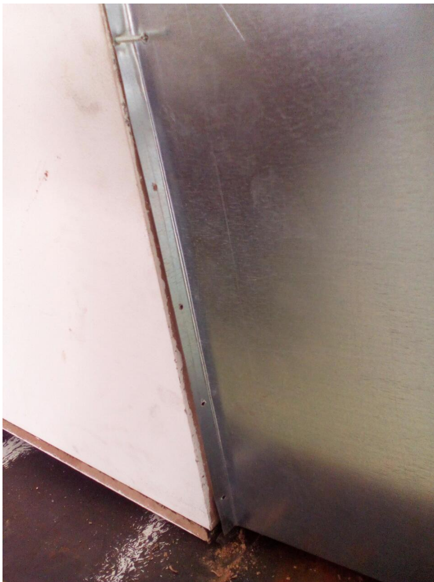
fig. 78 Πρόχειρη τοποθέτηση του υποδοχέα ανεμιστήρα με ξυλόβιδες.
