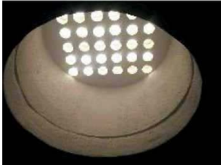
Σχήμα 19: Ανοίγματα οροφής
