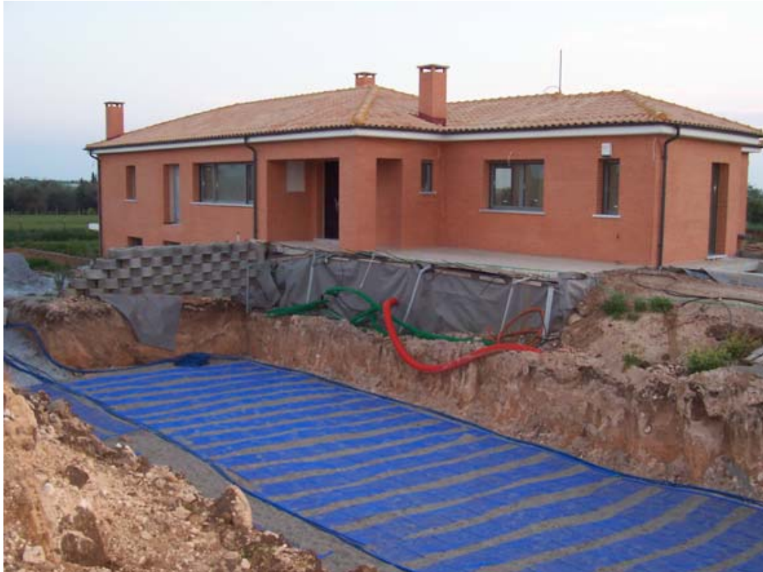
Σχήμα 5: Χρήση συστήματος γεωθερμικής αντλίας θερμότητας (τοποθέτηση οριζόντιου κλειστού κυκλώματος γεωεναλλάκτη) για την κάλυψη θερμικών αναγκών μονοκατοικίας 220 m 2 στην περιοχή Αγγελοχωρίου Θεσ/νίκης (στάδιο κατασκευής και ανάπτυξης)
