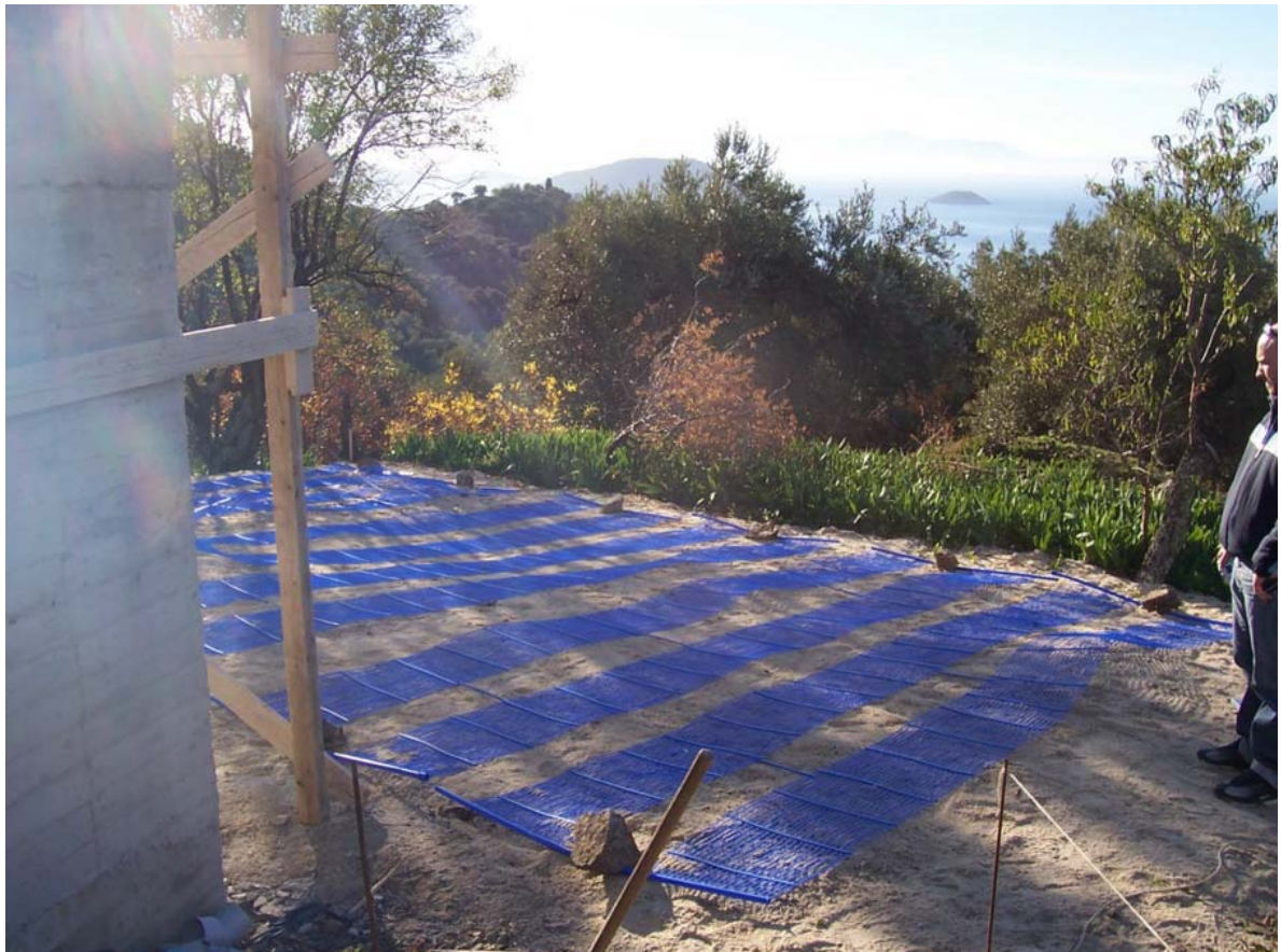
Σχήμα 7: Ανάπτυξη οριζόντιου κυκλώματος γεωεναλλάκτη για εγκατάσταση συστήματος γεωθερμικής αντλίας θερμότητας σε μικρή κατοικία στη Σκόπελο
