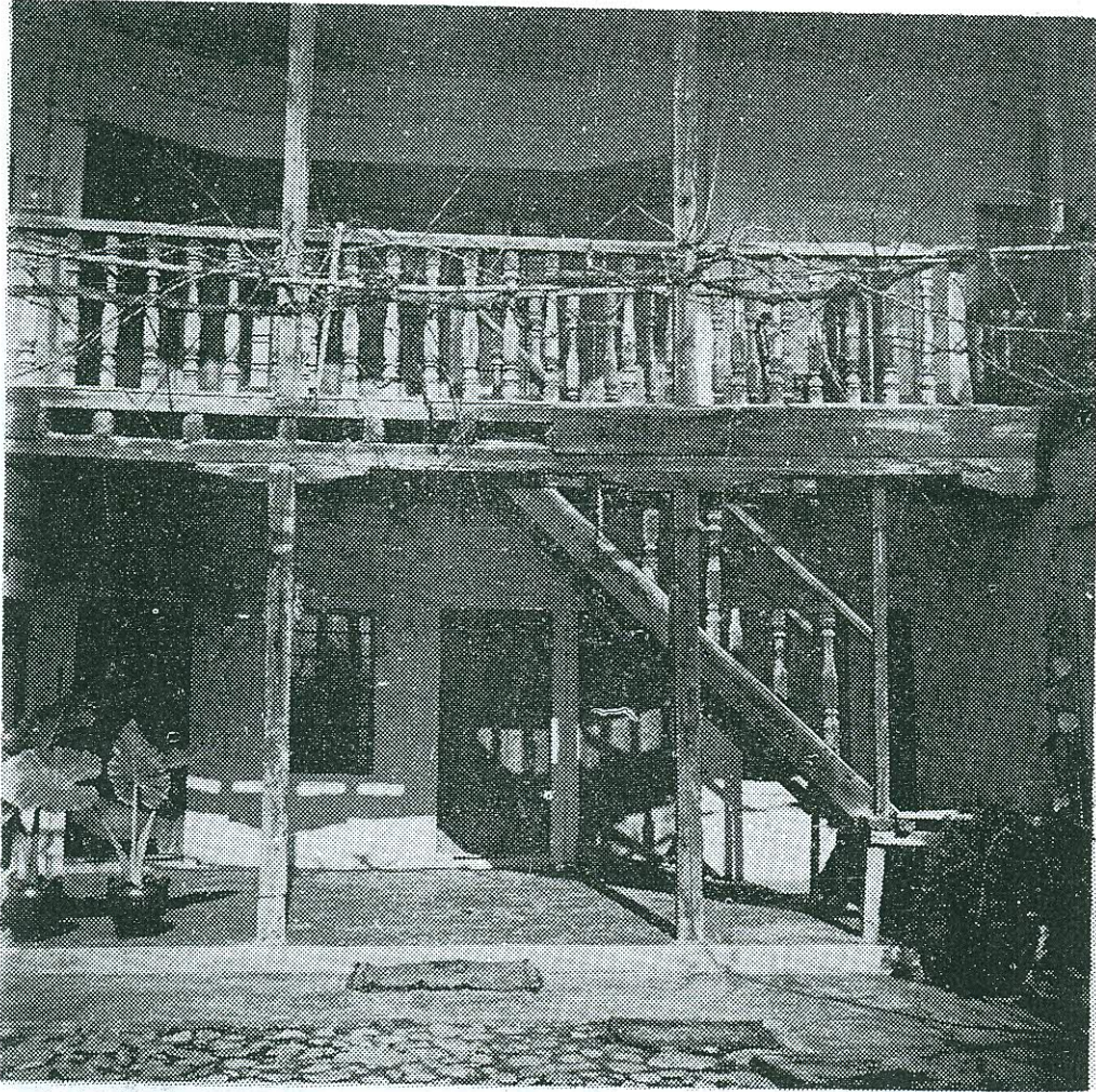
Εικ. 11. Τὸ σπίτι τοῦ Ζαπάρα. Λεπτομέρεια τοῦ κλιμακοστασίου.
