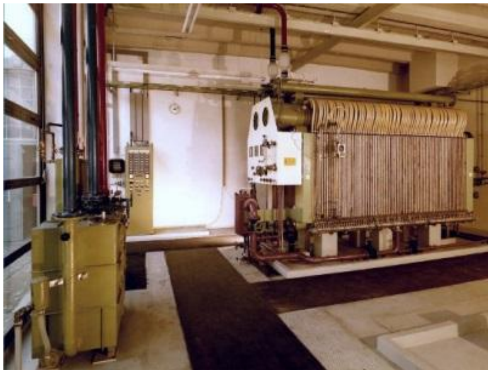
Εικόνα 17-9 Ηλεκτρόλυσης με τύπο «filter-press cell» , η εξωτερική όψη
