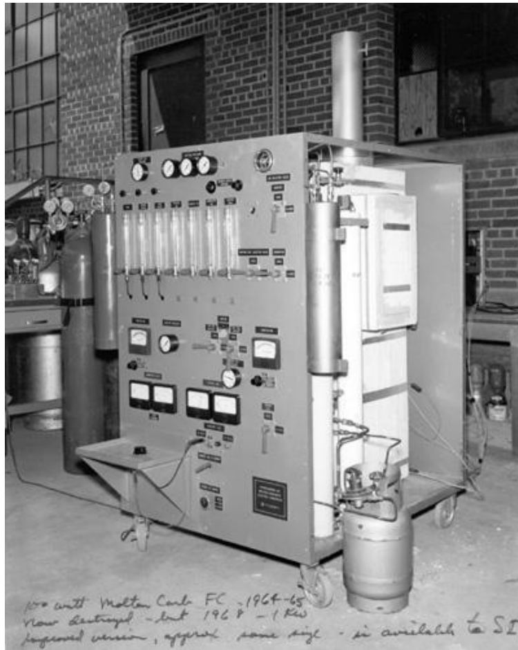
Εικόνα 6-7 photo of molten carbonate fuel cell, 1964, for the U.S. Army
