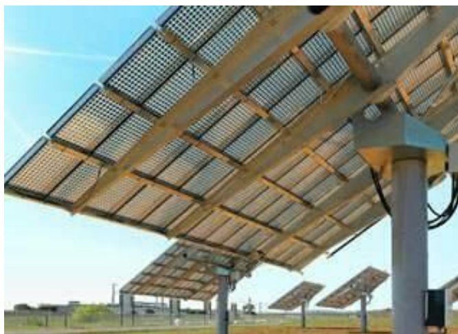
Εικόνα 3.15 - Στρεφόμενη συστοιχία δύο αξόνων.
