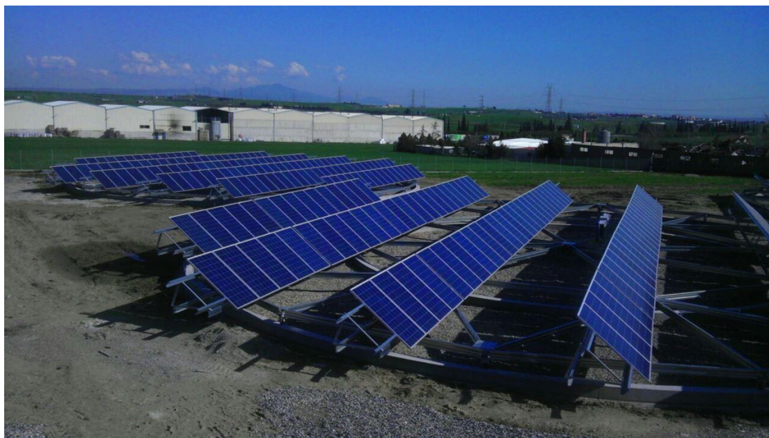
Εικόνα 3.14 - Στρεφόμενη συστοιχία ενός άξονα.
