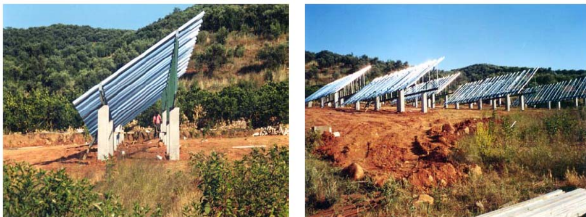
Εικόνα 9: Δομή στήριξης φωτοβολταϊκών κυψελών
