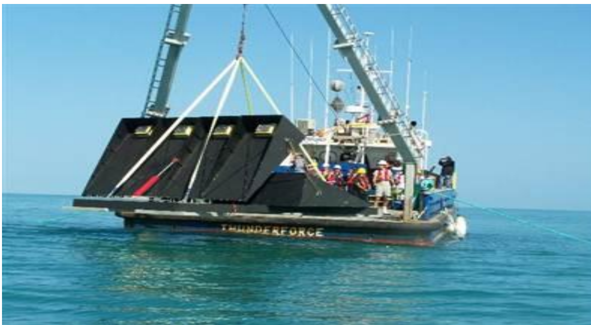
Εικόνα 2.8: Τοποθέτηση των WING WAVES.
