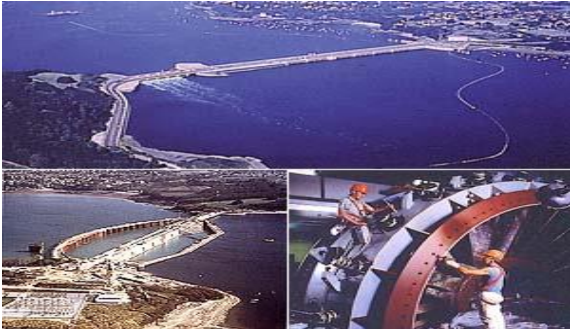
Εικόνα 1.5: Σταθμός παλιρροιακής παραγωγής ηλεκτρικού ρεύματος Rance.
