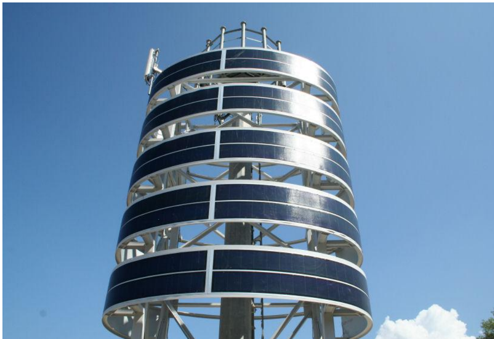
Εικόνα 1.2.1 : Κεραιές κινητής τηλεφωνίας με Υβριδικό συστήματα
