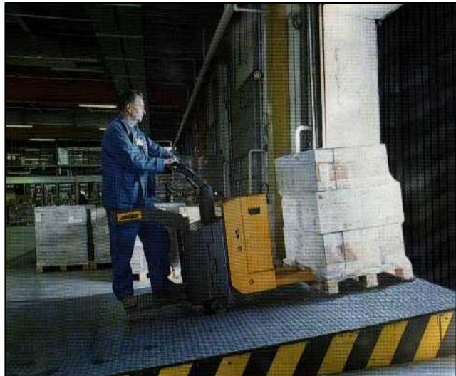
Εικόνα 4.3.2.α. Ράμπα εσωτερικού τύπου ανυψωμένη
