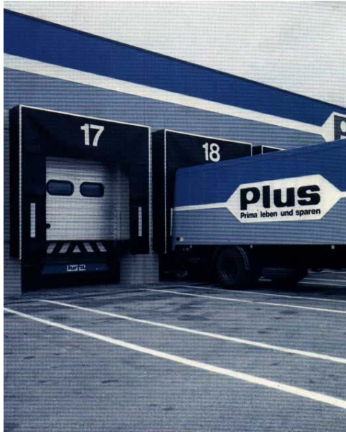
Εικόνα 4.8.3.β. στέγαστρο σταθερού σκελετού. Βλέπουμε τη πολύ καλή εφαρμογή του θαλάμου του φορτηγού κατά τη φορτοεκφόρτωση
