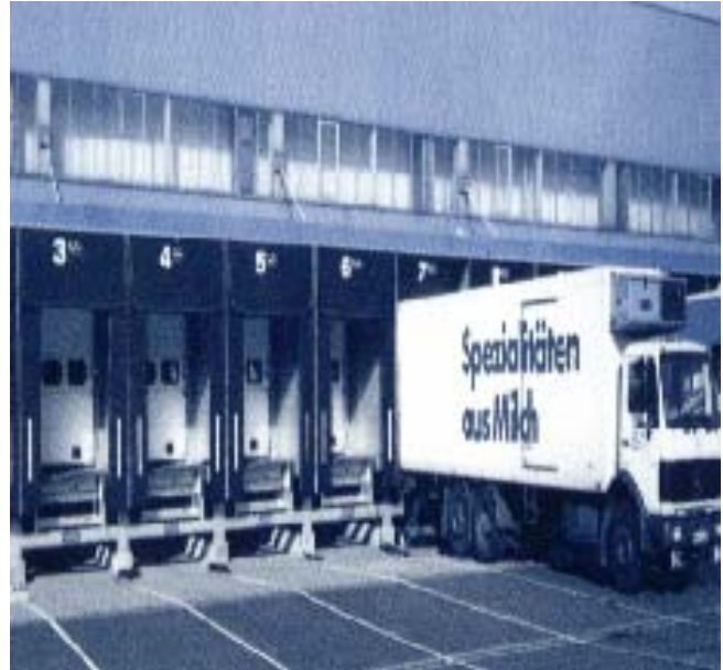
Εικόνα 4.8.4.β. διακρίνουμε την πολύ μικρή σκεπή που χρησιμοποιείται για να προστατεύουμε τα στέγαστρα από τις άσχημες καιρικές συνθήκες.
