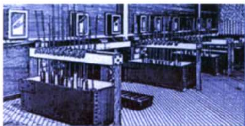
Η πρώτη εγκατάσταση βιομηχανικής παραγωγής αλουμινίου το 1888 ικανότητας 20 κιλών ημερησίως, στο Πίτσμποργκ των Η.Π.Α.
