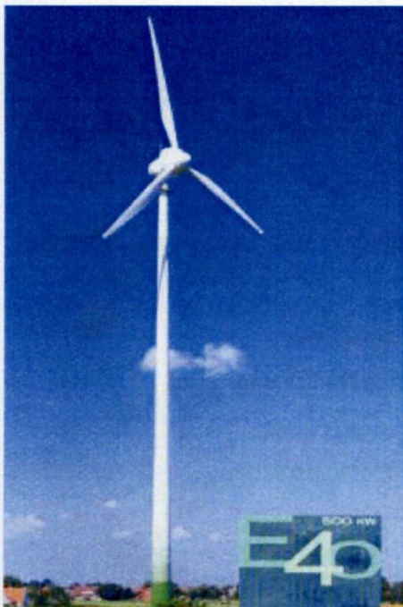
Εικ. 1 Ανεμογεννήτρια της εταιρίας Energon τύπου E40-500kW
