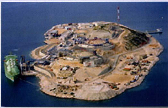
Σχήμα 6: Τερματικός σταθμός LNG στην Ρεβυθούσα
