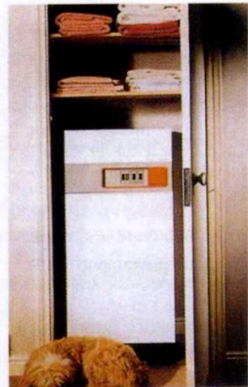
Λέβητας θέρμανσης κατοικίας
