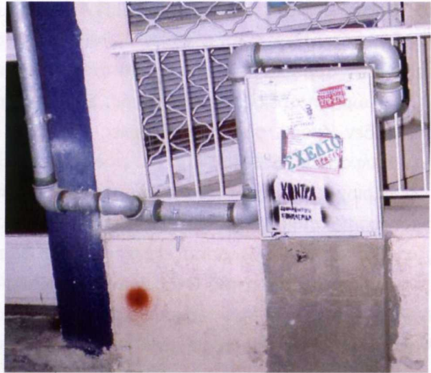
Σχήμα 19: Ρυθμιστής πίεσης στερεωμένος σε κάγκελα
