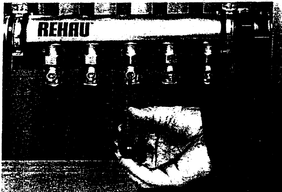
Σχήμα 8.19: Προρύθμιση της βαλβίδας ρύθμισης ακριβείας
