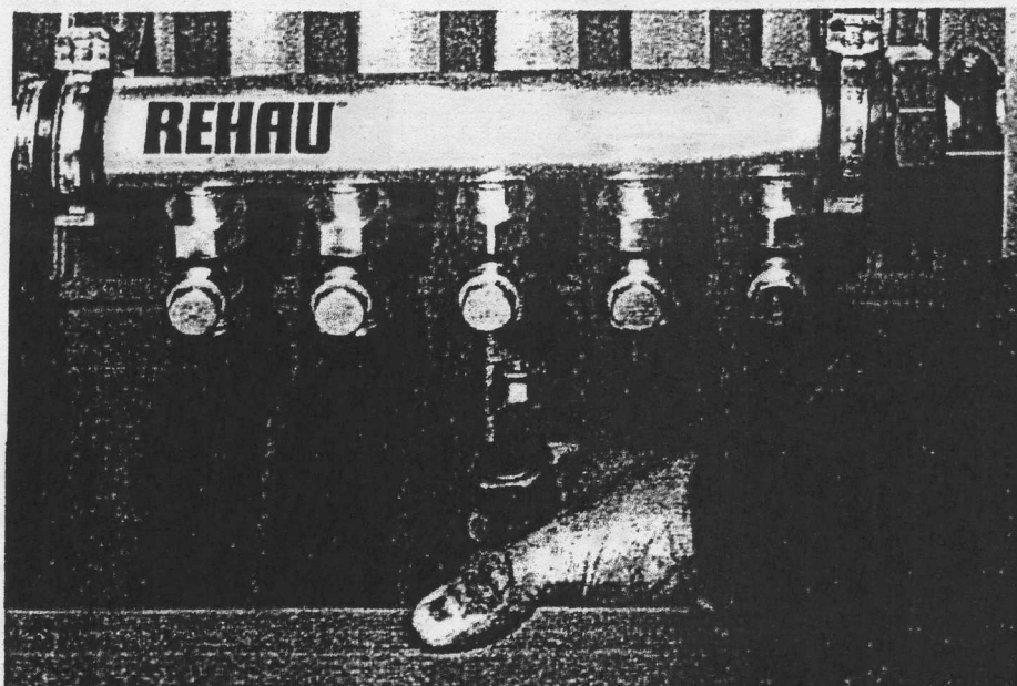
Σχήμα 8.9: Σύνδεση θερμοσωλήνα με την βαλβίδα προσαγωγής κυκλώματος θέρμανσης
