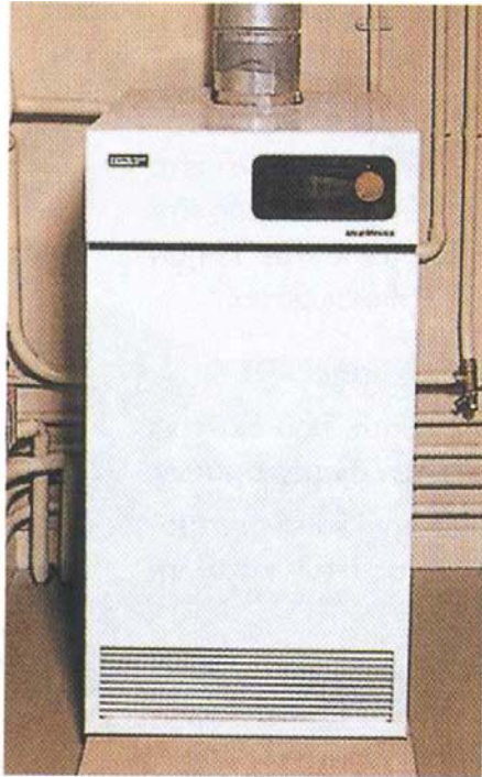
Λέβητας κεντρικής θέρμανσης Φυσικού Αερίου.
