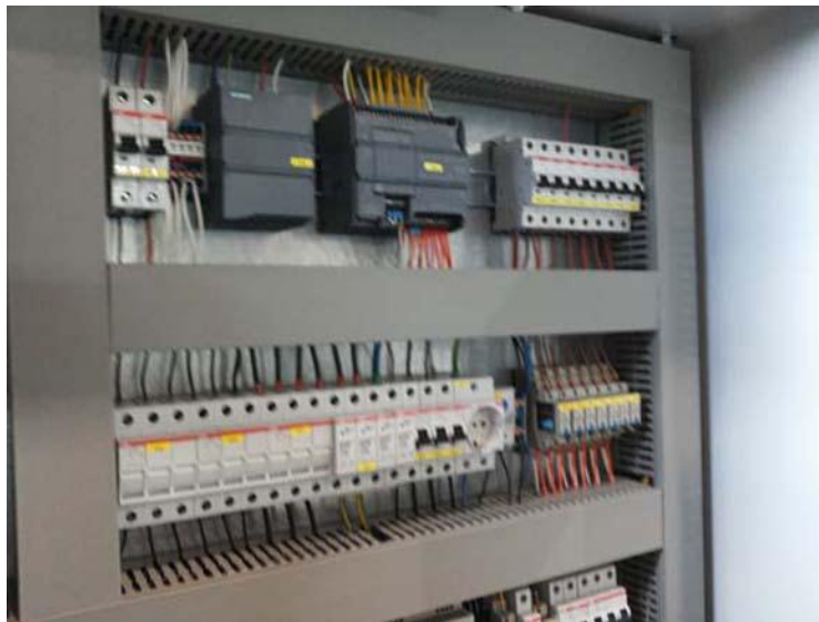
Εικόνα 1.4 : Αυτοματισμός με PLC
